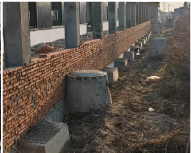
项目建设情况（排水工程）
