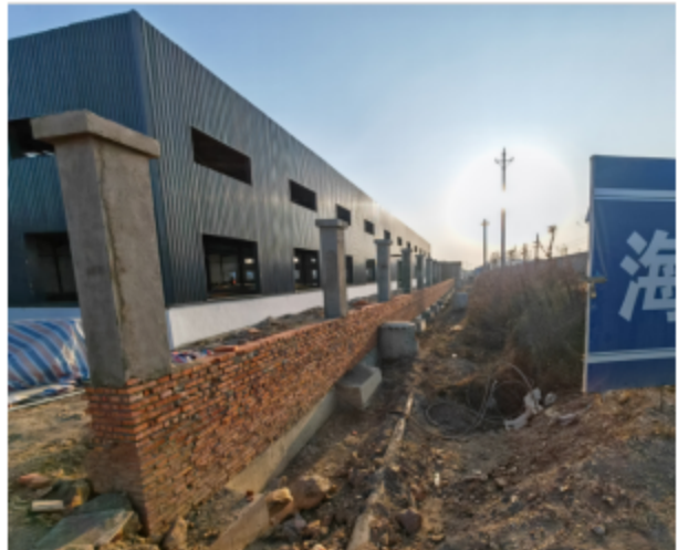
项目建设情况（在建1#车间）
