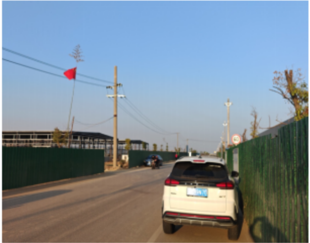
项目北侧现状（紧邻城南路）
