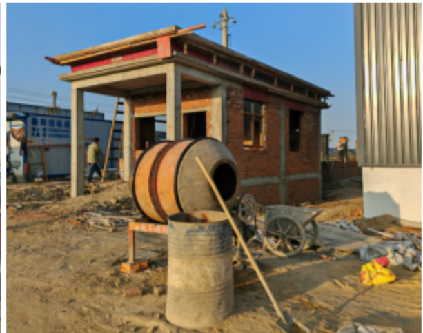
项目建设现状（在建门楼及施工区）
