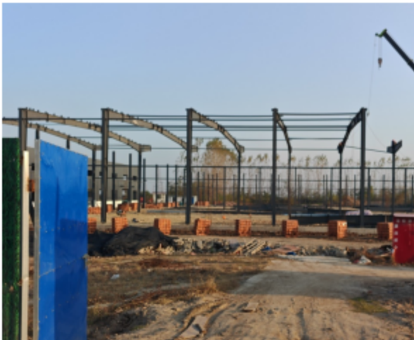
项目建设情况（在建2#车间）
