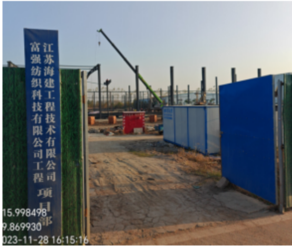
项目建设情况（施工主出入口）
