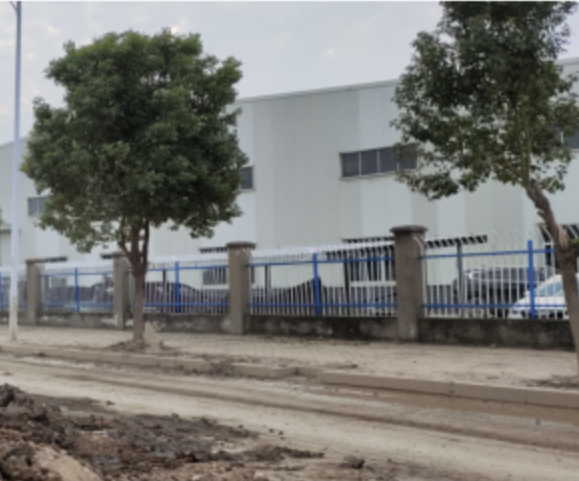
场地西侧现状（紧邻叶涛纺织在建项目）
