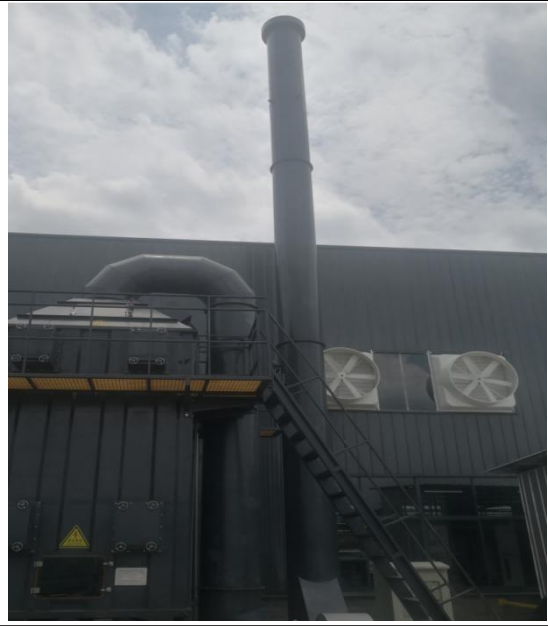
15m高排气筒及采样平台
