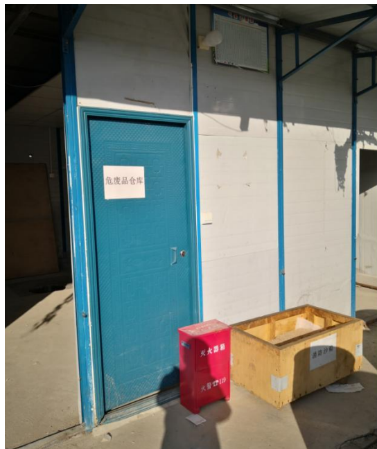
危险废物暂存间及消防物资
